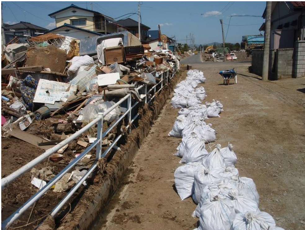
きれいになった側溝 土嚢袋130個の泥を掻き出しました。
